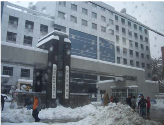
写真2：河北省地震局の建物。右の窓が小さい部分は後から増築した。
